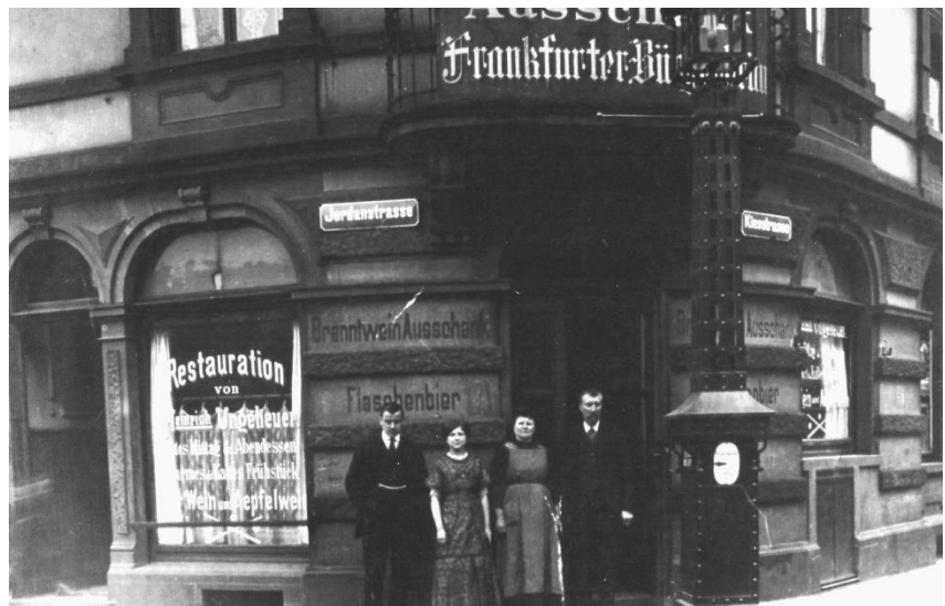
Eckhaus Jordanstraße 13 vor dem Zweiten Weltkrieg - Restauration Ungeheuer (neben der Metzgerei)
