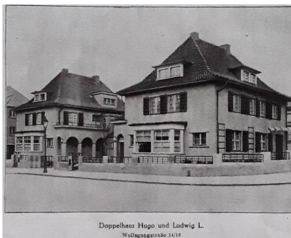
Die Häuser in der Wolfsgangstraße 14 und 16.
