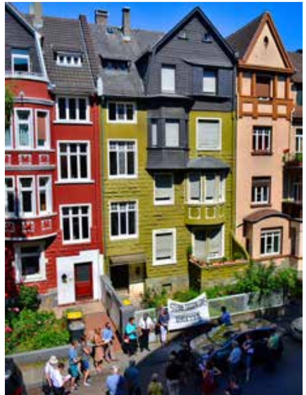
Bei der Verlegung
